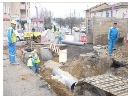
3 février 2009 : effondrement de la route de Valence au milieu du village (RD 67)
